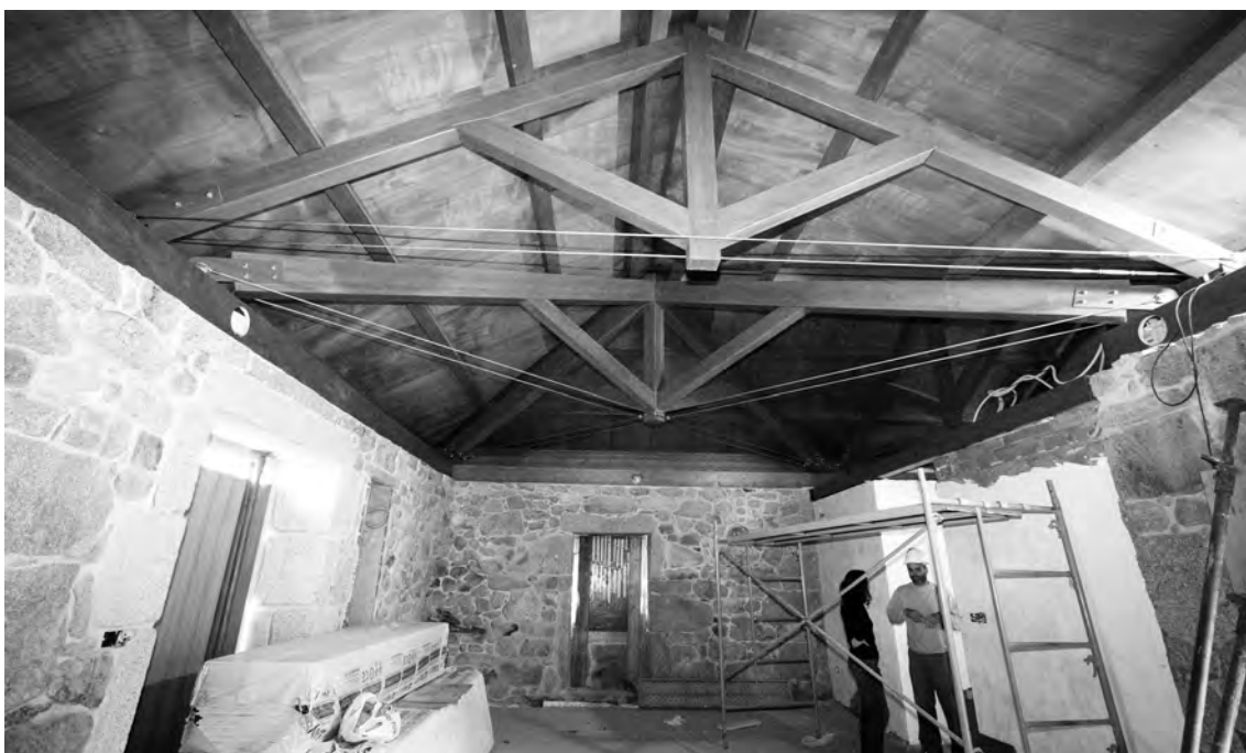
Cerchas e interior da rehabilitación da Casa das Nenas
