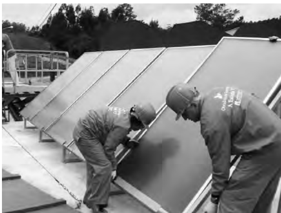
Colocación dos paneis solares
